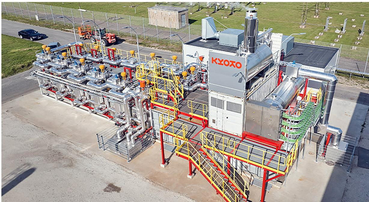
**Fig. 3:** El Heatcube de Norbis Park ha sustituido al carbón para la calefacción urbana en Aalborg (Dinamarca). Está cargado con 5 MW y presenta una capacidad de almacenamiento de 18 MWh. Este Heatcube reduce las emisiones en hasta 2000 toneladas de CO<sub>2</sub> al año.
